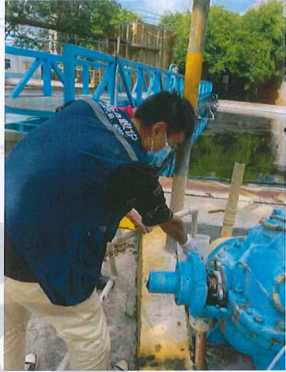
脱硫废水取水点
